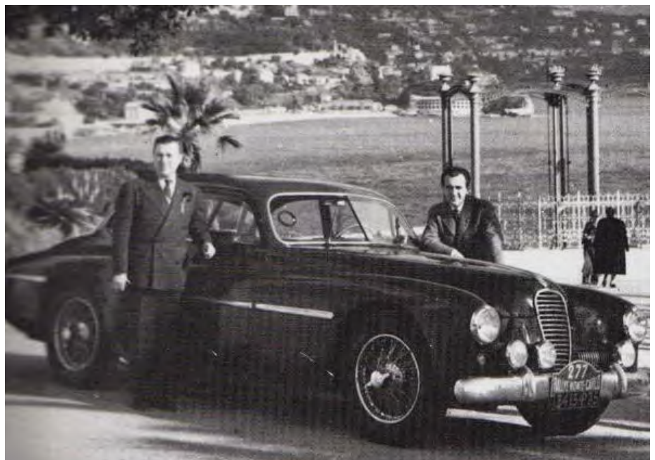
Totalvinnare av Rallye Monte Carlo 1951 Jean Trevoux och co-driver Roger Crovetto vid rallybilen, en Delahaye 175 S. Bilen hade en 6-cylindrig tävlingstrimmad motor på 4,5 liter som gav 220 hk, tre Strombergförgasare, preselectorlåda från Cotal och Rudge ekerhjul.
