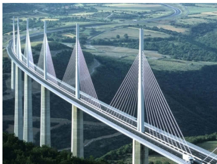
Viaduc de Millau. Arkitekt Michel Virlogeux. Höjd 343 m. Längd 2460 m. Spann mellan två pyloner 342 m. Bygget påbörjat 14/12 2001. Bron invigd 14/12 2004. Planerad livslängd 75 år.
